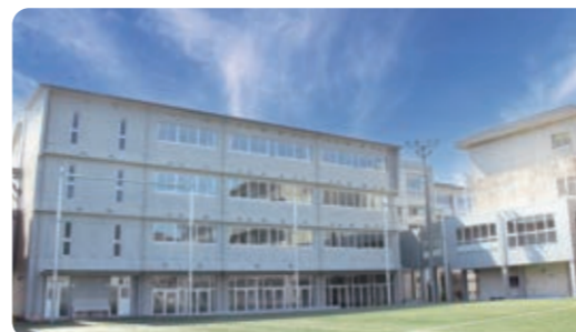
□1号館 東棟 2022年3月完成!
